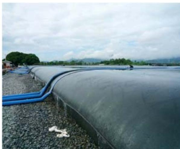
Figura 3 (a) - Exemplo de um dos “geobags” utilizados
