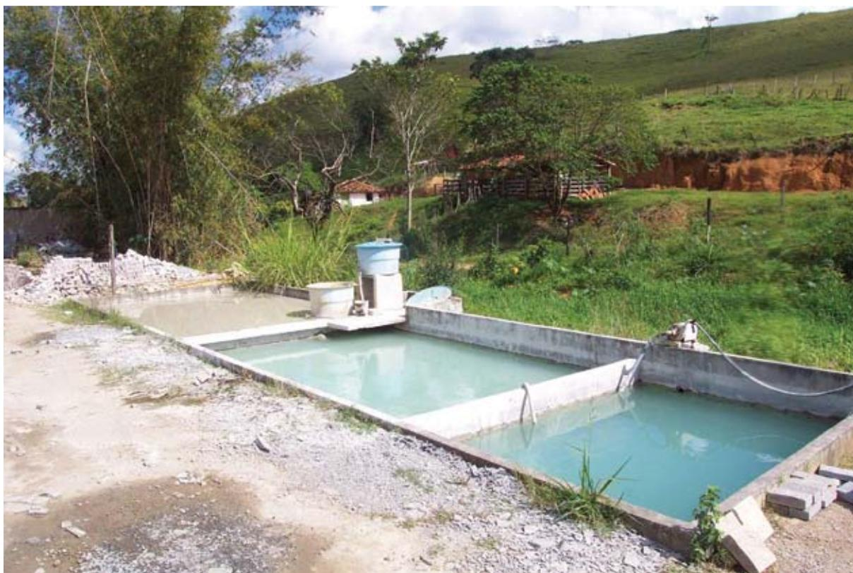
Figura 3 - Tanques de decantação instalados em uma serraria
