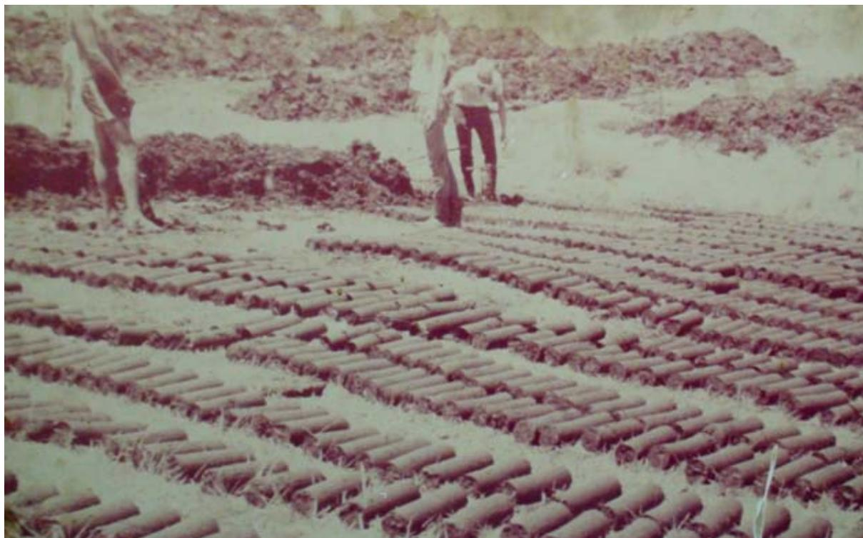
Figura 2 - Tarugos de turfa transportados da turfeira para o pátio da Cia. de Tecidos Rio Tinto (PB), aguardando para a queima nas fornalhas
