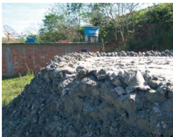
Figura 4 - Descarte de lama abrasiva
